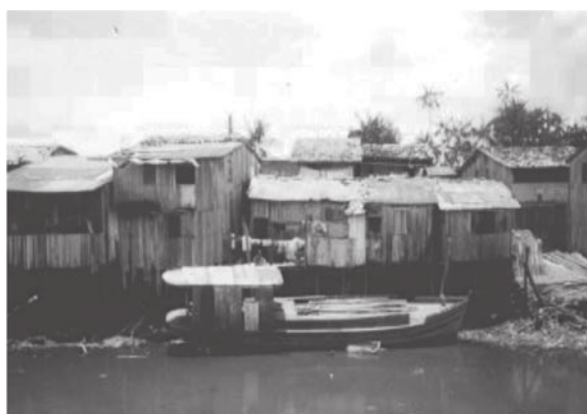
Foto 06 – Assentamento precário no município de Belém do Pará.
