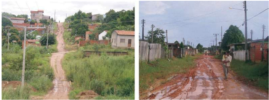
Foto 07 e 08: Loteamento irregular no município de Cuiabá no estado de Mato Grosso e no município de Rio Branco no Acre (2009). Foto: Rosana Denaldi
