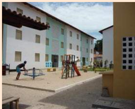
Conjunto Nossa Senhora de Fátima, Fortaleza/CE, 2009. Empreendimento PAC/HABITAFOR-CE. Foto Anja Nelle.
