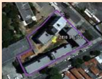
ZEIS de imóvel isolado, na Rua Olarias, região central de São Paulo
