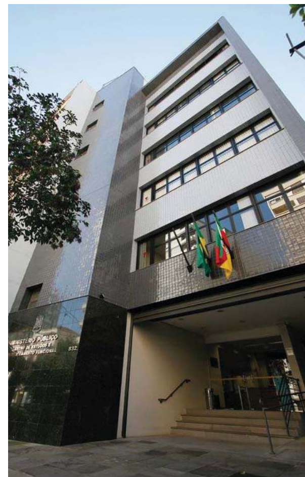
Prédio do Centro de Estudos e Aperfeiçoamento Funcional
